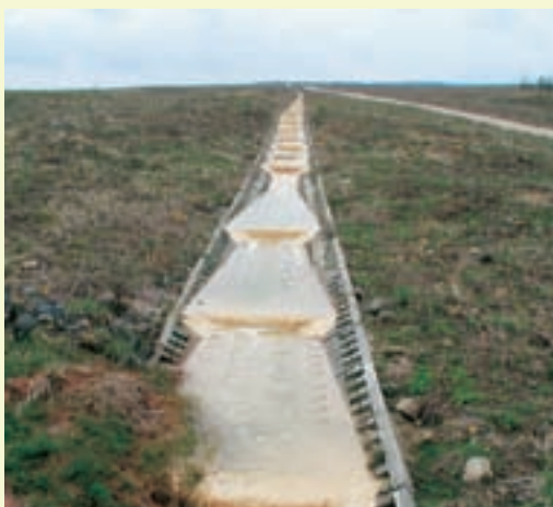
Dřevěné hrázky v odvodňovacích příkopech výrazně urychlují srážení uhlíkatů s možností pozdějšího samovolného se vyvíjejícího koryta. ❖
